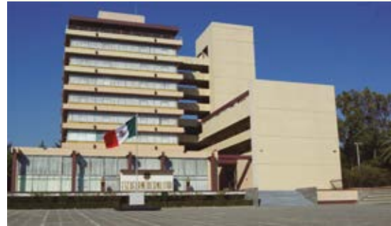
Figura 13. Fachada de la Escuela Médico Militar de Lomas de Sotelo II (1976-2015). Archivo fotográfico de la CEHEMM.
