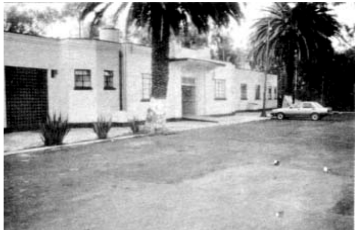
Figura 1. Aspecto exterior del primer edificio.
