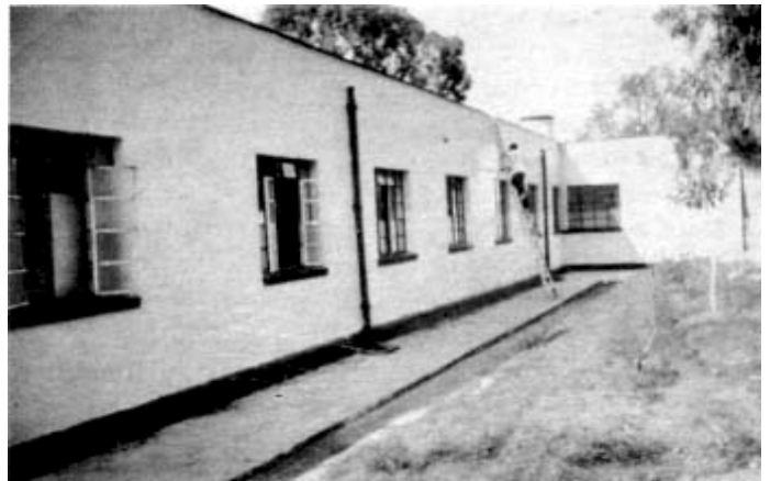
Figura 2. Aspecto interior del primer edificio.
